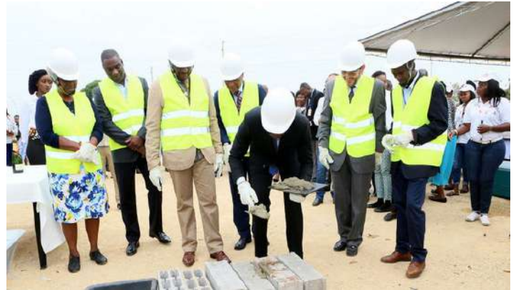
Lançamento da primeira pedra na construção do Laboratório Central da Água.
